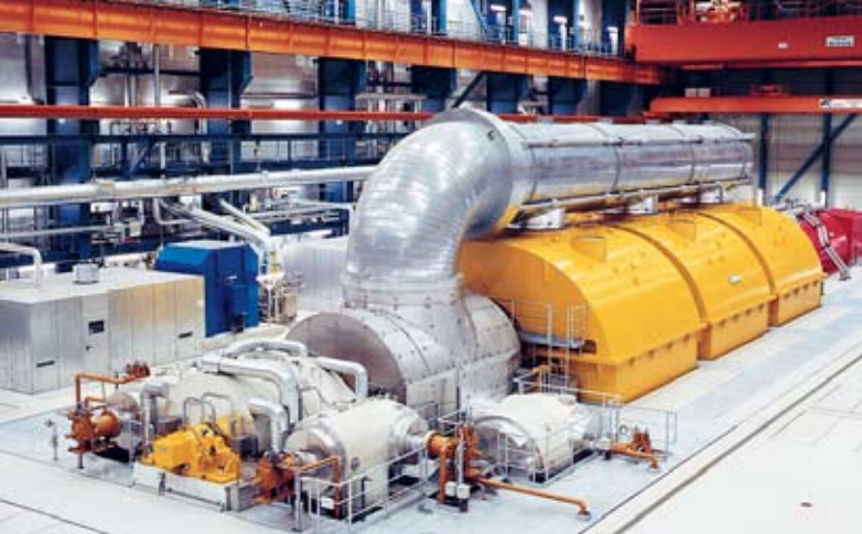
Turbinska dvorana s parovodom
